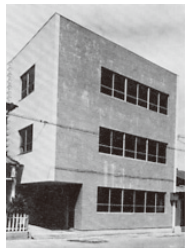
日豊商事 社屋(昭和39年9月竣工)
