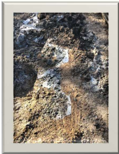
鋼矢板の形状で固化した 充填材(引抜き直後)
