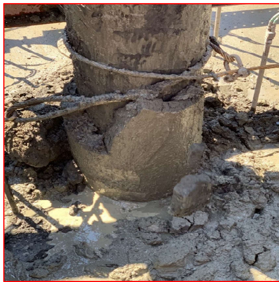
杭の引抜きにも使えます
