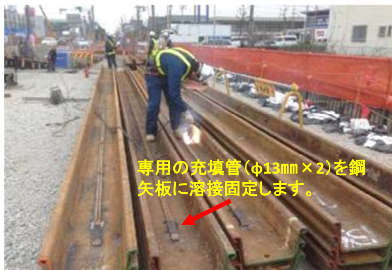
CASE1.鋼矢板打設前に充填管を設置する場合 (YT-1工法)
