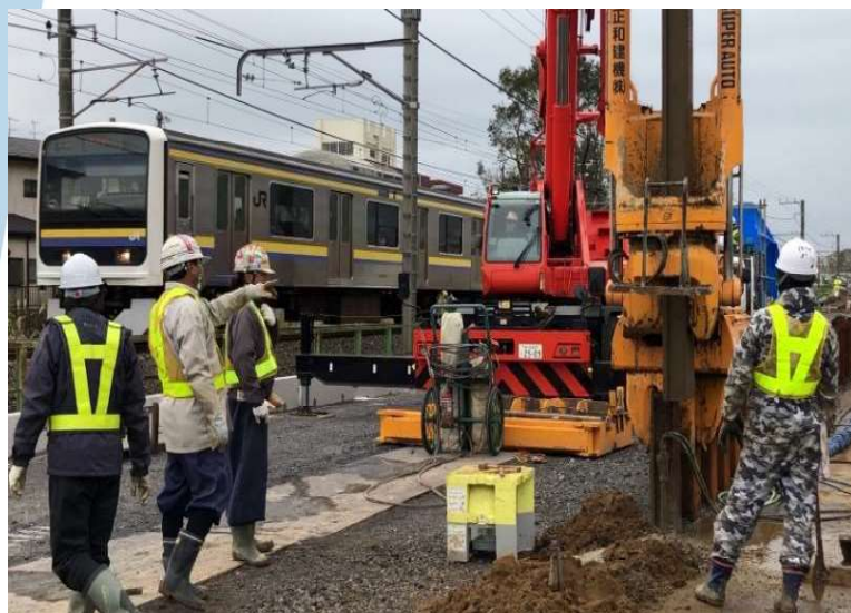
鉄道近接工事の実績あり
